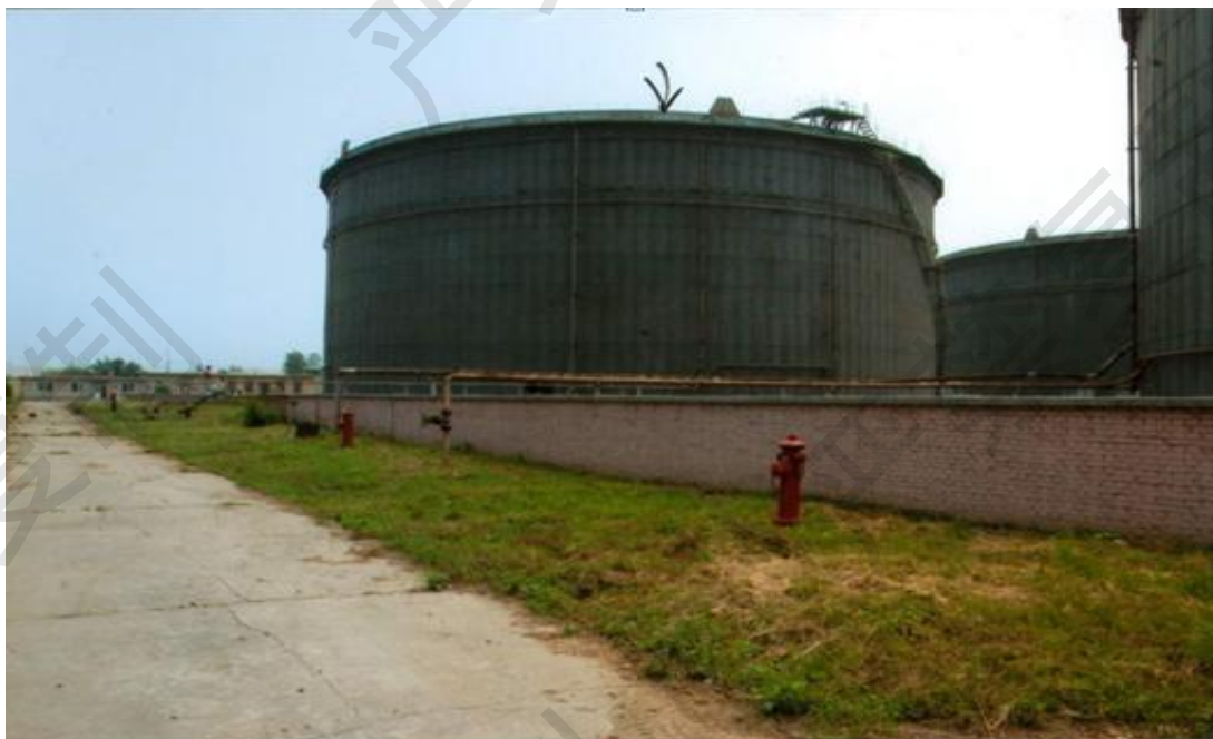
图 1 C1-7 罐现场照片
